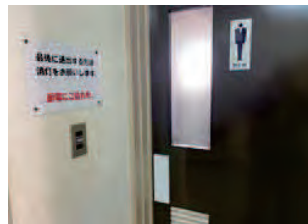
・トイレのドアを直接触らなくても開閉できるようノブを改良した。
