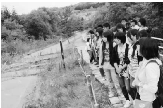
図4 道路の上昇と落差1mの断層
